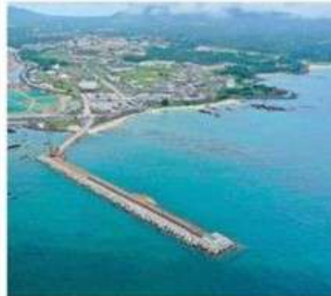
埋め立てや護岸工事が進むキャンプ・シュワブ沿岸部。右側の大浦湾には軟弱地盤が広がる=12日午前、名護市辺野古(小型無人機で撮影)
