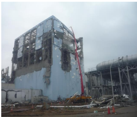
福島第一原発4号炉貯蔵プールの冷却
