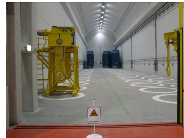
管管理棟の下に掘られたトンネル ネッカーヴェストハイム原発 ドイツ
