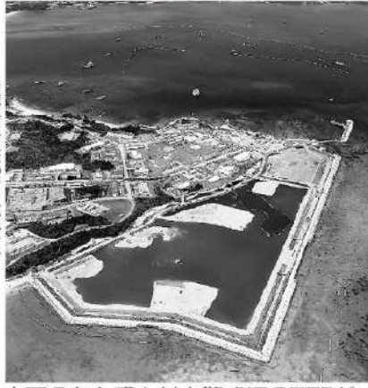
辺野古沿岸部で土砂投入 (共同通信社機から)
